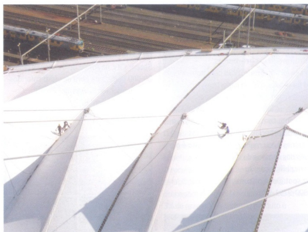
A água da chuva que escoar pelas membranas é coletada por uma calha no anel de compressão
