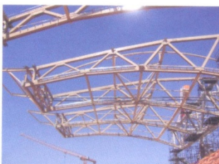
Estrutura curva, em aço, usada para receber a cobertura e a fachada montada com painéis
