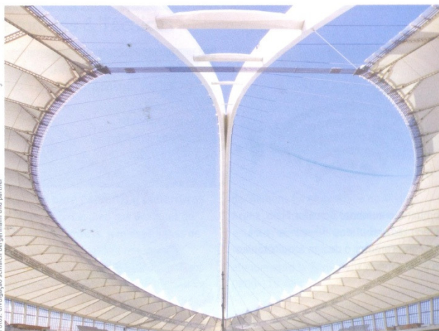
As membranas tensionadas estão na maioria dos estádios construídos nos últimos anos
